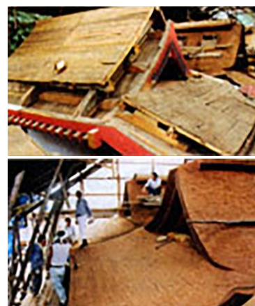
本社本殿檜皮屋根の葺き替え
