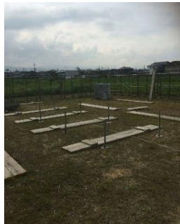
丸太足場制作のための足場の設置を開始
