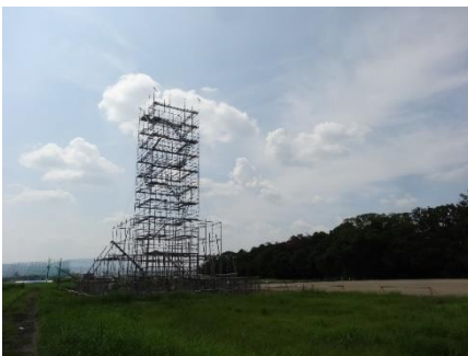
丸太足場制作のための足場を設置
