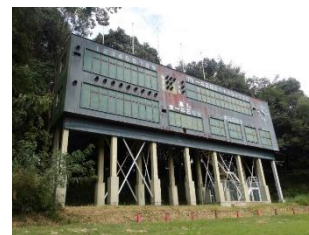
昭和50年建築の スコアボード
