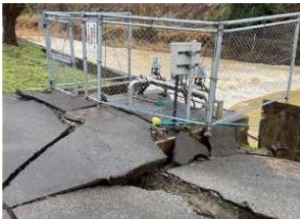
珠洲市宝立浄水場（取水口）
