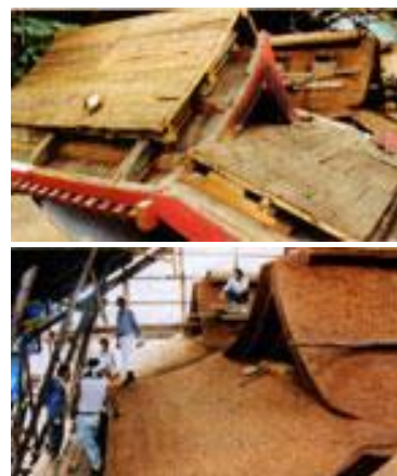
本社本殿檜皮屋根の葺き替え
