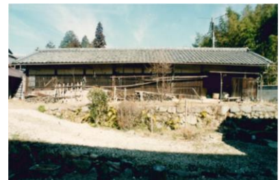
田原地区の民家に残るかつての 茶工場
