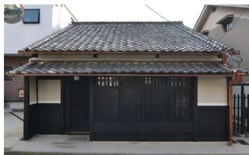
【修理後】 令和5年12月7日撮影
