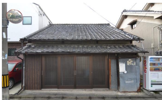
【修理前】 令和4年12月6日撮影
