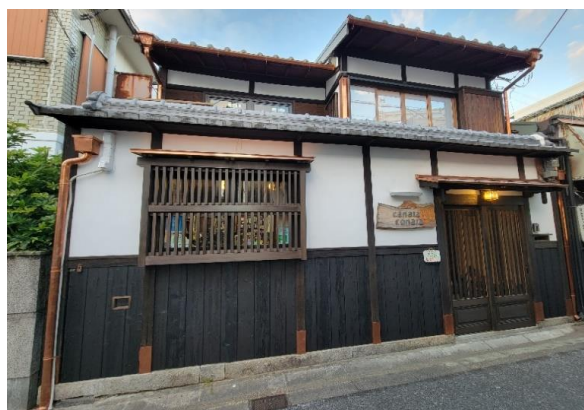
【修景後】 令和4年12月15日撮影
