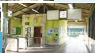
改札・ホームへの動線が階段のみの平城山駅（外観と改札口）
