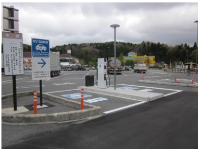
道の駅針テラス 急速充電設備
