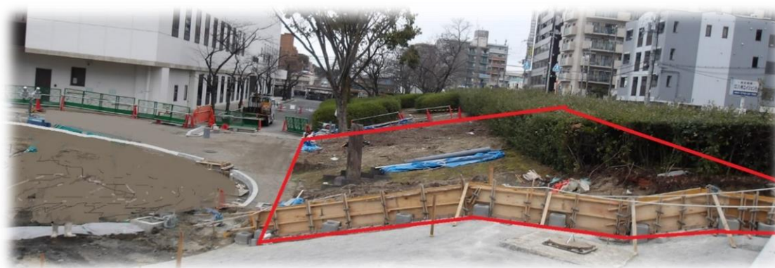
【本庁舎南側広場整備（令和6年2月撮影）】
