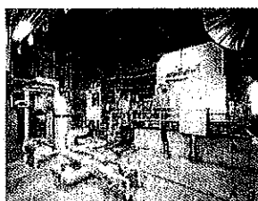
ゴミ発電設備 (蒸気タービン発電機)
