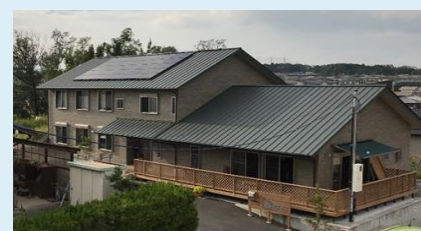
市民共同発電所（2019年完成）
