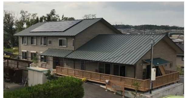
図 18 市民共同発電所（2019年完成）
