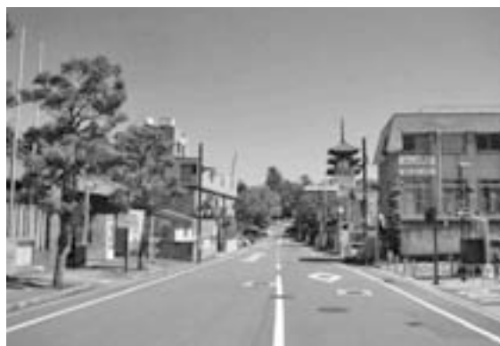
電線共同溝（東寺林町周辺）
