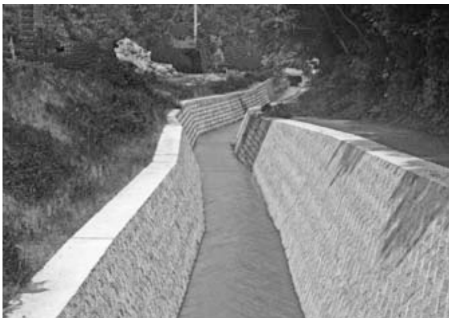
改修された普通河川
