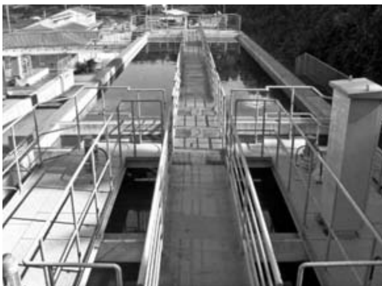
都祁浄水場（都祁馬場町）
