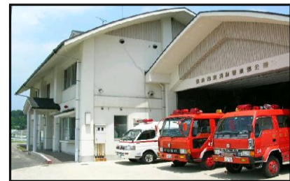
東消防署東部分署
