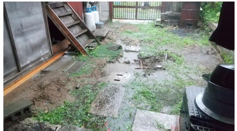
作業風景2：作業中に大雨が降ってきて、床下に雨が流れ込んできました。慌てて会所に雨道を作り対策しました。
