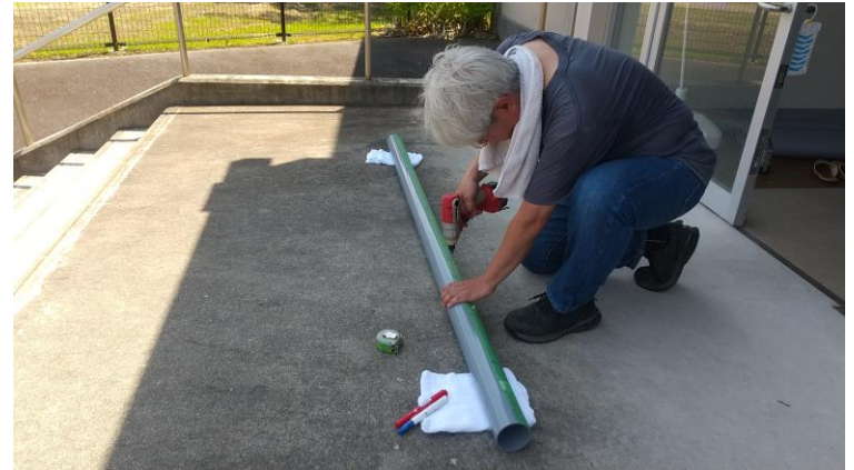
作業風景1：湿気対策のパイプを加工しています
