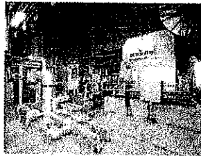
ごみ発電設備 (蒸気タービン発電機)
