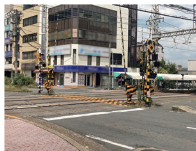
速やかな安全対策が求められる 新大宮第1号踏切（新大宮駅東側）
