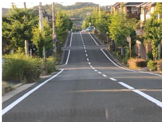
中央線、路側線の塗り直し
