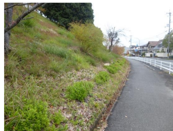
見通しの悪い場所の樹木伐採
