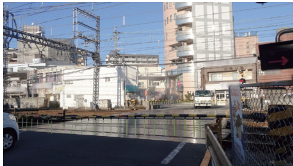
移設工事が予定されている菖蒲池8号踏切
