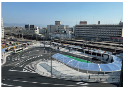
整備が完了した 近鉄大和西大寺駅北口駅前広場
