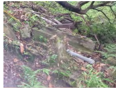
P-9 コンクリート片、鉄片、パイプ
