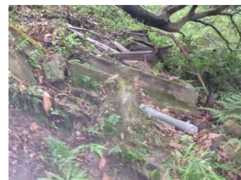
P-20 B-13付近の斜面 コンクリート片等の廃材 が多量に認められる
