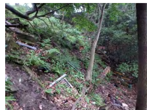
P-18 B-14、B-18付近 斜面上に廃材が散在する
