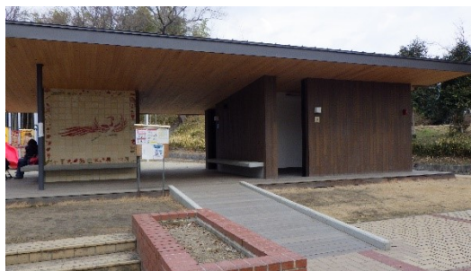
公園内に設置されたスロープ
