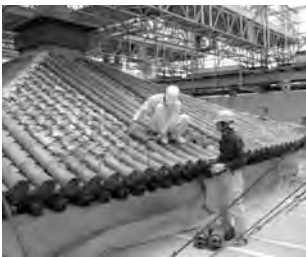
解体修理中の東塔（瓦下ろし）
