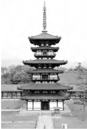
薬師寺東塔（解体修理前）
