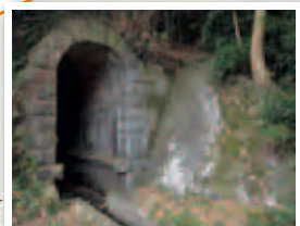
●鹿川隧道 農業用水路の目的で造られた石組みのトンネル。現在も利用されています。
