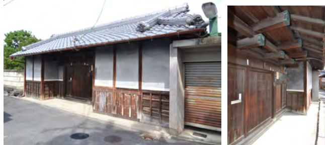
長屋門 片側切妻片側入母屋造 南面に構える。腰壁の一部を竹張りとしている。出桁 が二段である。
