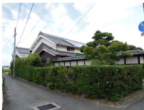
主屋 切妻造（落棟） 約100年前の大正期の建築を近年改装。元の屋根にはムクリが付いていた。
