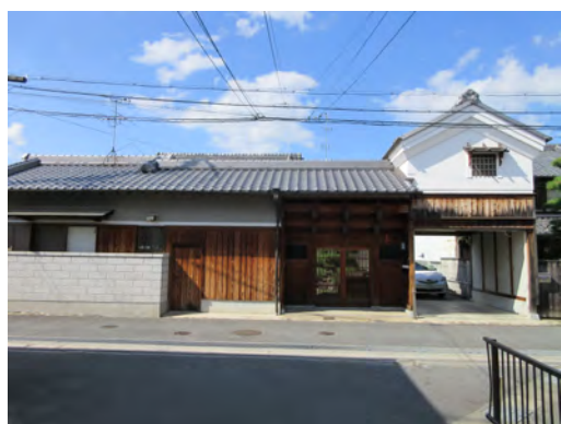
長屋門 近年の建築だが、出入口の両脇に蔵や納屋、離れ等を接続する伝統的な長屋門の形態をよく踏襲している。
