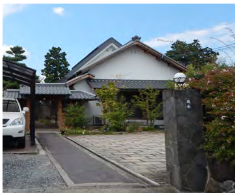
主屋 切妻造（大和棟） 明治頃の建築とみられる。草葺部分は金属板で覆われている。落棟部分は棧瓦葺。
