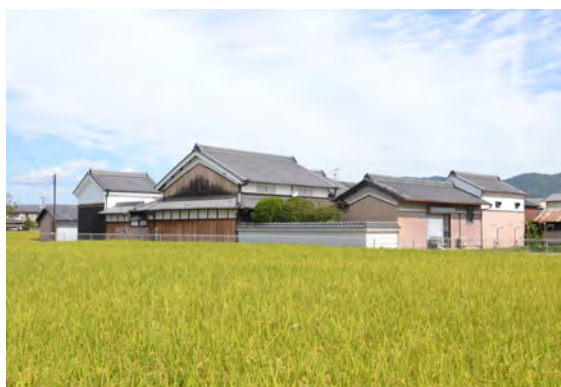
囲造りの屋敷構え 主屋、長屋門、離れ、納屋、巽蔵、乾蔵等からなる囲 造り。主屋一階に太格子、つし二階に虫籠窓、袖卯建。
