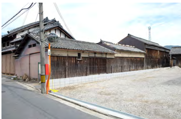
納屋2棟と蔵 3棟が1列に接続。中央の納屋は本瓦葺で小丸窓が特徴的。足元は低い石積みで敷地の高低差を処理。
