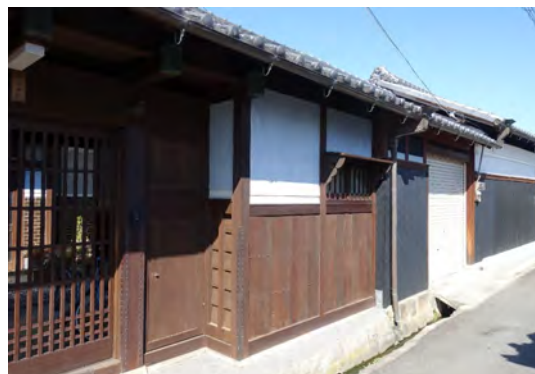
長屋門 片側切妻片側入母屋造
