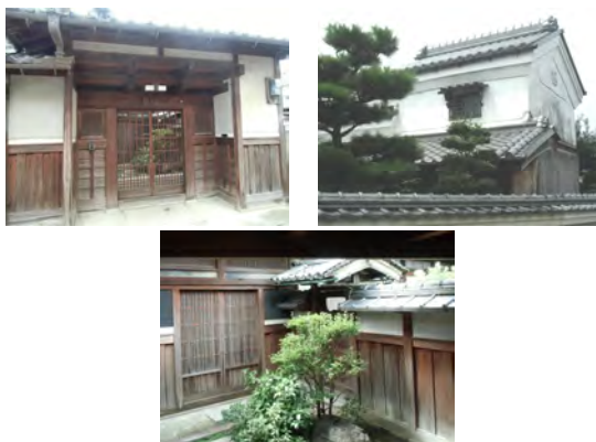
附属屋（長屋門・塀重門・蔵） 長屋門を入ると、玄関前と座敷前庭を区画する腰板張漆喰塗の塀と塀重門がある。座敷前庭の上手に乾蔵。
