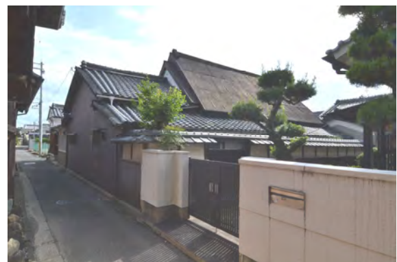
主屋 切妻造（大和棟） 明治頃の建築とみられる。 草葺の屋根は金属板葺となっている。
