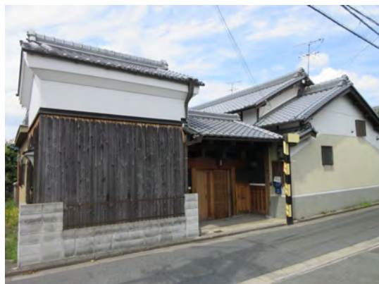
蔵・門・主屋 門に続く主屋は新しく見えるが戦後の築造か。壁、屋根の改修時に煙出しを撤去したと思われる。
