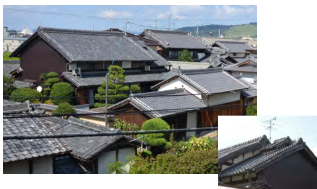
主屋 切妻造(落棟) 戦後の建築とみられる。落棟に煙出しが残る。大戸口脇には玄関を張り出さずに設けている。
