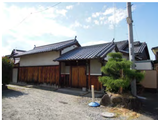
長屋門 門と納屋部の棟高の違いが変化を与える。棟端の鬼瓦上の鳥ぶすま瓦が印象的で、デザインを引き締める。
