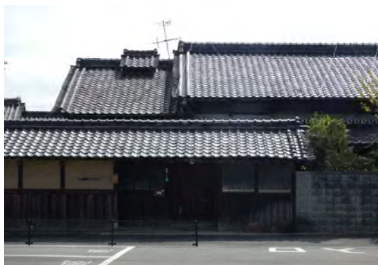
主屋 切妻造（落棟） つし二階の農家。囲造りの屋敷構え。煙出しあり。 瓦屋根が美しい。
