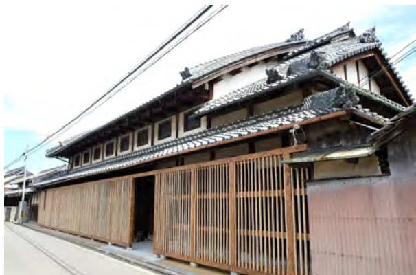
主屋 入母屋造（落棟） 昭和初期頃とみられる町家。太格子、出格子あり。前面の柵は近年取替。つしの窓に鉄格子。正面庇は板軒。
