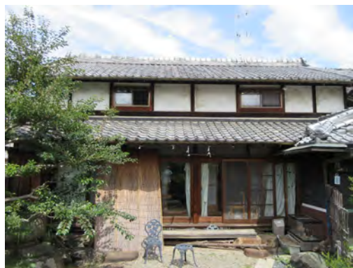
主屋 切妻造(落棟) つし二階の農家型住宅。落棟に煙出しが残る。戦後の建築か。南に張出玄関があるが元は北が入口という。
