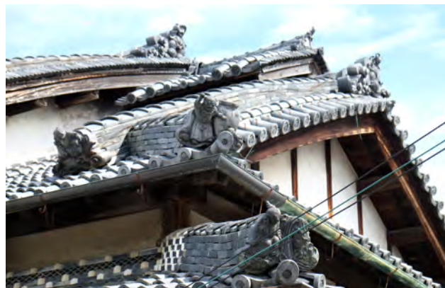
主屋 入母屋造（落棟）煙出し 装飾瓦 軒瓦に家の紋をあしらい、七福神の鬼瓦で飾る。落棟に煙出しが残る。上手にも小さく落棟をつくる。
