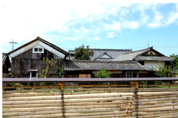
主屋背面 蔵、納屋、離れ 左側に大きな蔵。中央奥の主屋背面に入母屋妻入の張出部あり。右側の離れも入母屋造の大きな建物。
