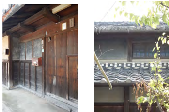
長屋門・主屋つし二階ガラス窓 長屋門は北面に構える。出桁は一段。主屋のガラス窓 は縦棧のみのシンプルな意匠で、外側に鉄格子が入る。
