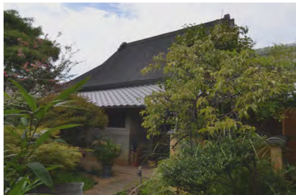
主屋 片側切妻片側入母屋造（大和棟） 明治頃の建築とみられる。 草葺の屋根は、昭和35年に金属板葺にしたという。
