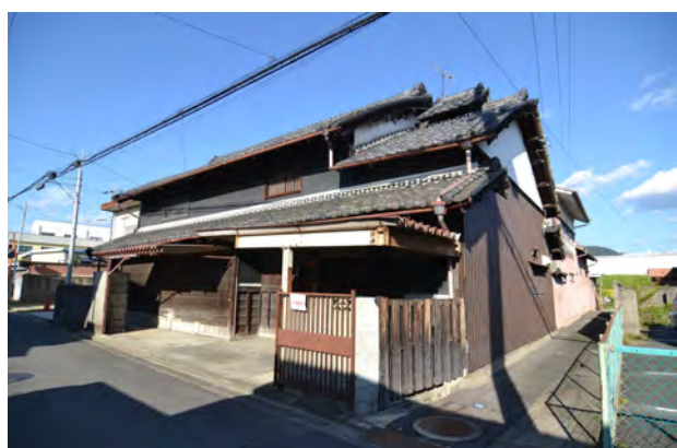
主屋 切妻造（落棟） 集落北部、街道東側。正面は黒漆喰塗、側面は白漆喰塗。屋根にむくり。太格子・平格子あり。
