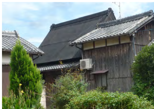
主屋 切妻造（大和棟） 通りに北面して建つ。明治頃の建築とみられる。 草葺の屋根は金属板葺となっている。
