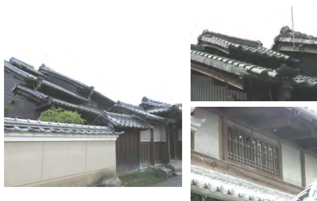
主屋 切妻造（落棟） 戦前の建築とみられる。つし二階建。落棟に煙出しが残る。軒を出桁で支持し、つしの窓に平格子。
