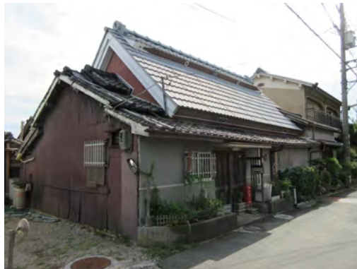
主屋 切妻造（大和棟） 通りに北面して建つ。明治頃の建築か。落棟に煙出しが残る。草葺の屋根は瓦葺型の金属板葺となっている。
