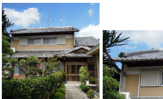
主屋 切妻造（落棟）張出玄関付 戦後の建築。本二階建てで下手を落棟とする。家紋付き袖卯建があり、屋根にはムクリがつく。
