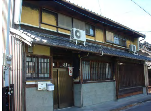
上街道沿いの町家形式の住宅 昭和初期頃の建物。平格子、吹寄親子格子、丸棒格子、棧を割り付けた硝子窓、外壁の黄色土壁等がみられる。
