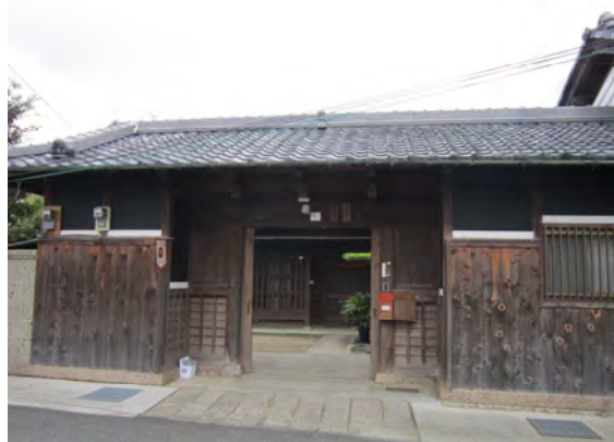
長屋門 片入母屋造、棧瓦葺、平入、出桁2段。昭和30年代以降の建築。主屋は昭和6年の建築（上棟御幣あり）。
