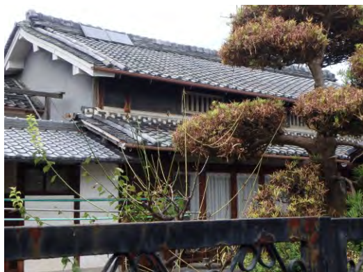
主屋 つし二階、虫籠窓付の建物。大正から戦前頃の建築か。しっかりとした造りが外観からも窺える。
