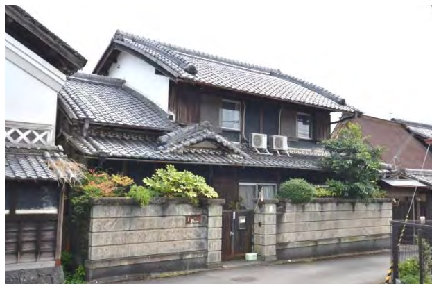
主屋 本二階 切妻造 道路に近い位置に建つため、玄関を張り出さず、底上に千鳥破風を置く。大屋根と落棟にはむくりが付く。
