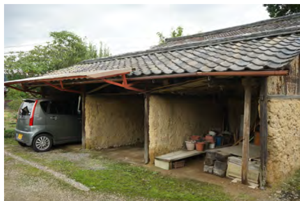
ドケ屋 土壁の壁体に木造の屋根をかけた小屋。車庫として今も現役。
