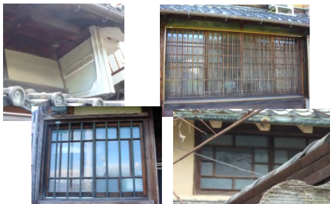
袖卯建、格子、棧を割り付けた硝子窓 袖卯建、吹寄親子格子、丸棒格子、棧を割り付けた硝子窓の意匠。
