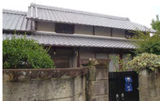
主屋 切妻つし2階建 街道の一つ南の道沿い、天理教教会東側に建つ農家。
