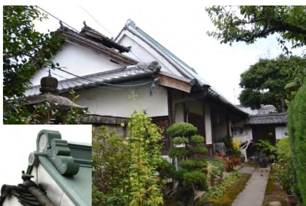
主屋(大和棟) 高塀 落棟 煙出し 元大庄屋で大きな屋敷構えである。幕末頃の建築。高塀に鳩の棟飾りが付く。大和棟の形態が良く残る。
