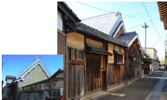
大和棟の主屋 門は、入口庇を檜皮葺、軒を一文字瓦葺とし、出格子窓を付けた、瀟洒な数寄屋風意匠。
