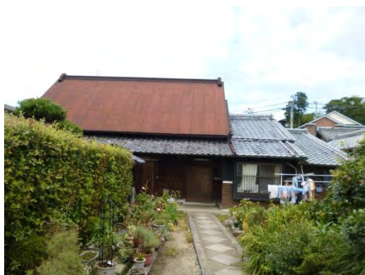
主屋（大和棟） 江戸末期から明治初期の建築と推定。40年前の改修時に煙出しを撤去。
