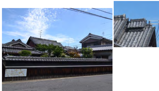
主屋 切妻造（落棟） 大正～戦前頃の建築か。つし二階は、棧を割り付けた硝子窓に平格子を入れる。落棟部に煙出しを有する。
