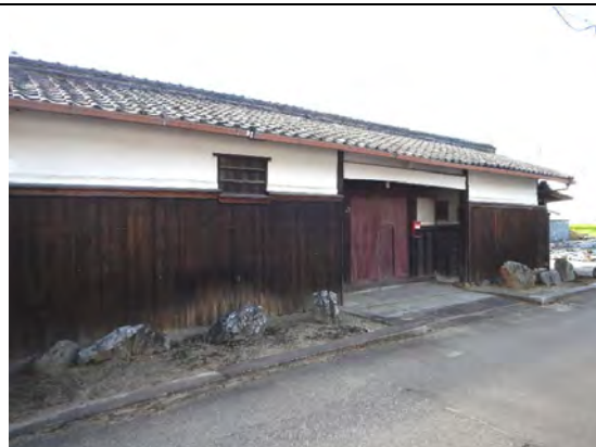
長屋門 歴史的形式で、棧瓦葺、大戸口、与力窓がある。
