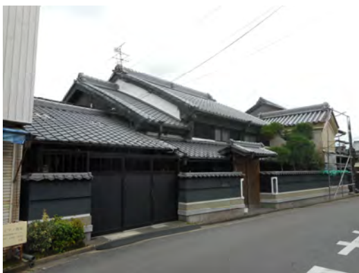
主屋 入母屋本2階建て J R 桜井線東側、街道沿いに建つ。むくり屋根、黒漆喰。軒先鉢巻・出桁・破風板・袖卯建を銅板張とする。特徴的で整った意匠。蔵外壁改装工事中、本瓦葺。 備考
