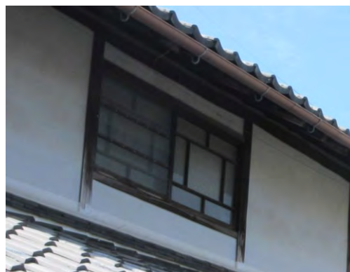
棧を割り付けた木製硝子窓 大正期から昭和初期にかけての建物によくみられる窓形状。「おたふく窓」と呼ぶことがあるらしい。
