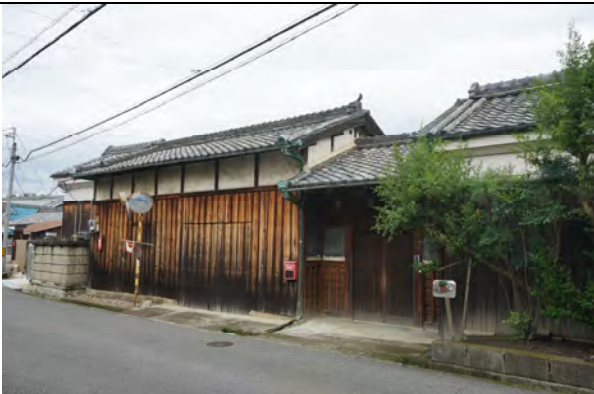
長屋門（主屋 切妻本2階建） 街道沿いに長屋門がある囲造りの農家。落棟。北側離れの外に掘池と1階CB造の新しいドテ屋がある。
