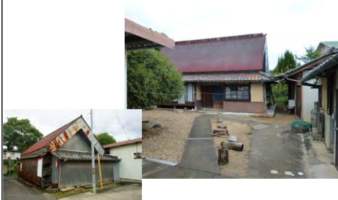
主屋 切妻平屋建 街道から路地に入った所に建つ。草葺を鉄板で覆う。西側にほぼ同規模の草葺鉄板覆いの納屋あり。
