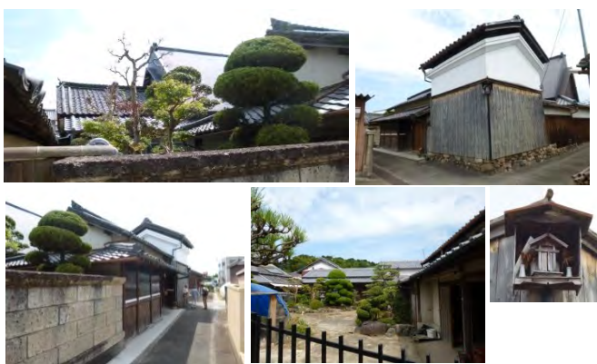
主屋（大和棟）・長屋門・乾蔵・中庭 広い中庭はかつては靱を干す場所であったが今は庭園となっている。明治初期の建築と推定。
