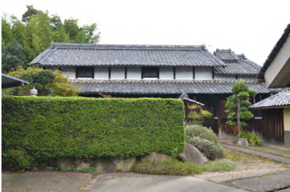
主屋 切妻つし2階 街道から路地に入った正面突当りに建つ。庭に塀重門あり。落棟で煙出しがある。昭和30年代の建築という。
