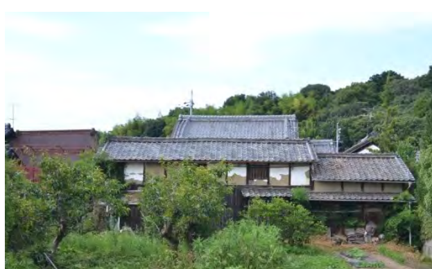
納屋 切妻造 敷地南側に建つ納屋。自然の素材で景観が構成されており、主屋と附属屋の葺の重なりが美しい。
