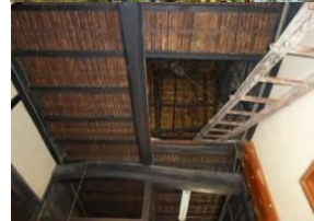
長屋門・乾蔵・塀重門 長屋門は離れと納屋が付く。右下は主屋「通り庭」の天井で、簀子天井の上に土を置いた大和天井。
