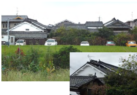
主屋と附属屋が構成する屋敷構え 広い敷地に主屋、納屋、離れ、蔵が建ち並ぶ。 主屋には煙出しもみられる。明治頃の建築か。
