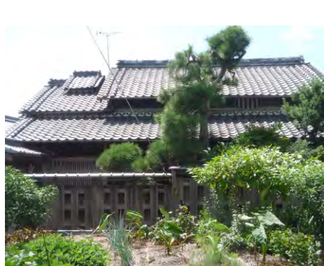
主屋 切妻造（落棟） 昭和初期の建築という。虫籠窓を有するつし二階建。落棟部に煙出しを有する。
