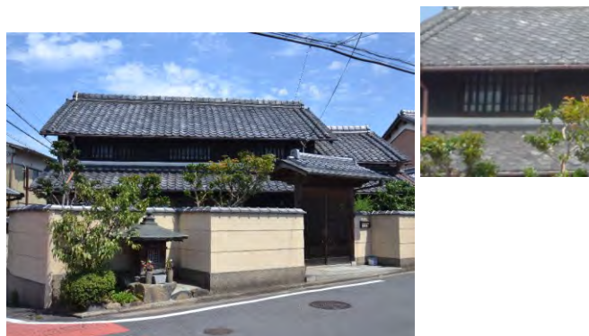
主屋 切妻造（落棟） 戦前の建築とみられる。つし二階は、棧を割り付けた硝子窓に平格子を入れる。煙出しなし。
