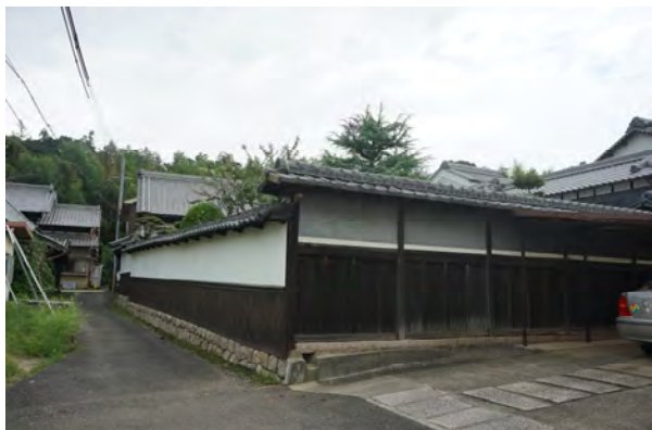
高塀の景観（主屋 切妻つし2階） 街道から路地に入った所に建つ和風住宅。南と西側を高塀で囲み周囲の景観を形成している。農家か。
