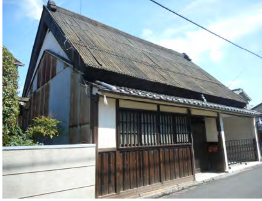
主屋 切妻草葺(鉄板葺)
