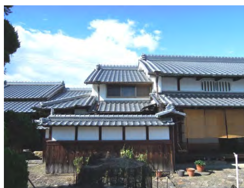
主屋 門を入ったところにある真壁塀。囲われた中庭があるのだろう。袖卯建、虫籠窓等丁寧な仕事が見てとれる。
