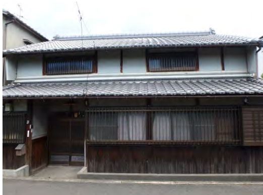
上街道沿いの町家形式の住宅 戦前頃の建築か。母屋はすべて丸太材を用いている。
