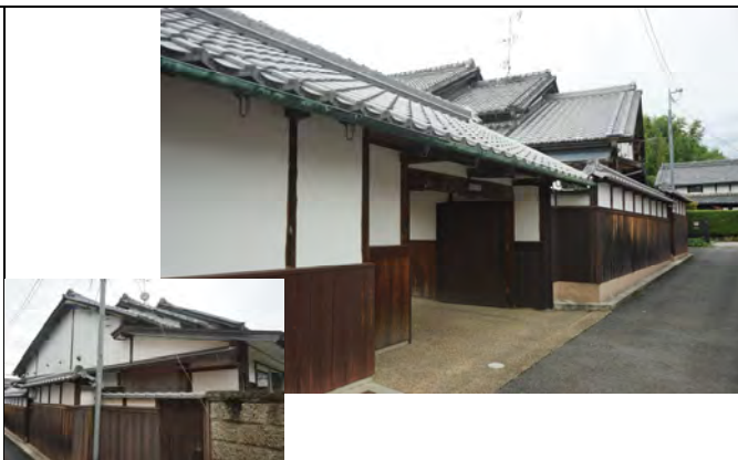
長屋門（主屋 切妻本2階建） 東側に長屋門があり主屋南に庭がある囲造りの農家。落棟で出桁あり。東側に真壁塀があり景観を形成する。
