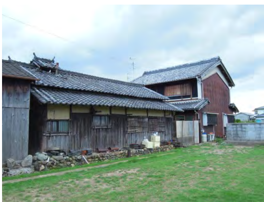
旧主屋（背面側） 平屋建。明治頃の建築か。煙出しの屋根に鳥ぶすまがついている。右奥に新しい主屋が建つ。
