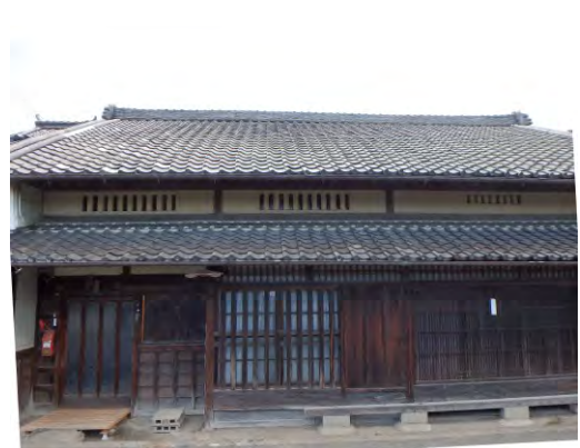
上街道沿いの町家形式の住宅 明治頃の建築か。平格子、太格子、虫籠窓のバランスが美しい。
