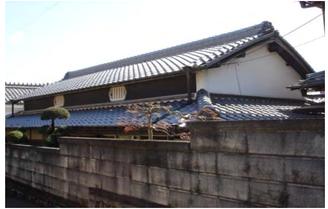
主屋 切妻 つし部の外壁は大壁漆喰塗り仕上げ。虫籠窓を備えている。
