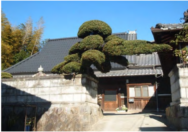
主屋 片側切妻片側入母屋(落棟) 大正12年(1923)に建築されたという農家。上手を入母屋造とし、下手は大和棟となる。
