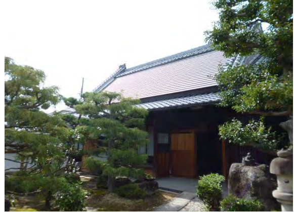
主屋 大和棟 主屋は明治27年(1894)建築。高塀造の大和棟。
