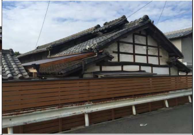
主屋 明治期の建築と思われ、煙出し・虫籠窓がある。低く落ち着いたプロポーション。
