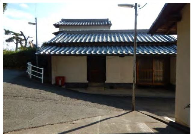
附属屋 道路を挟んだ向かいの公民館に附属する倉庫と思われる、一部土蔵風の意匠をもつ。
