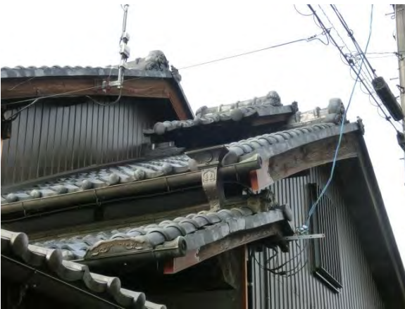
屋根構成 切妻、落棟、煙出し、下屋。
