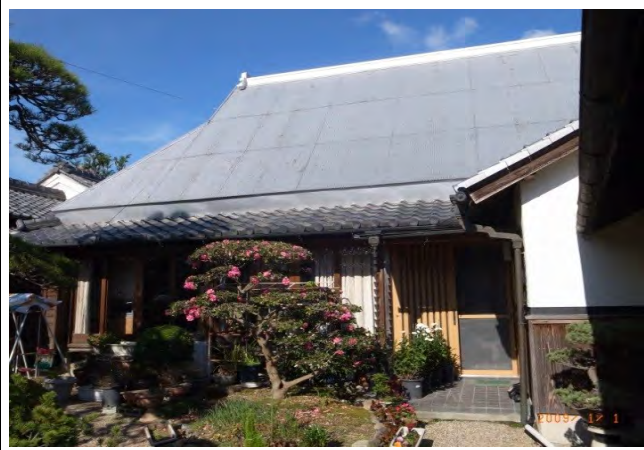
主屋 入母屋 明治以前に建築されたとみられ、草葺であったが現在は金属板が張られる。煙返しの大梁は撤去されている。
