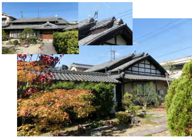
主屋 切妻(落棟) 落棟部に煙出しが付いている。妻壁の貫を現しとしている。入母屋妻入の張出玄関は後補か。
