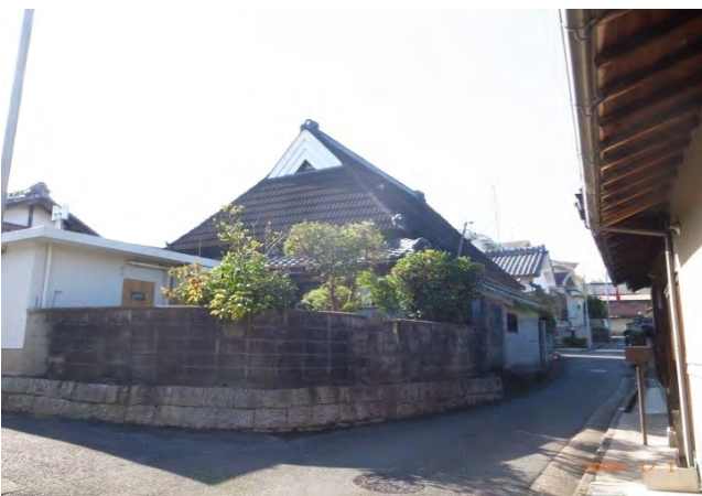
主屋 入母屋 大正11年(1922)築とされ、当初草葺であったが現在はスレート葺となっている。下屋は瓦葺である。
