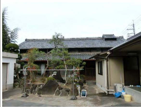
主屋 すっきりと伸びた切妻屋根に煙出しがアクセントになっている。
