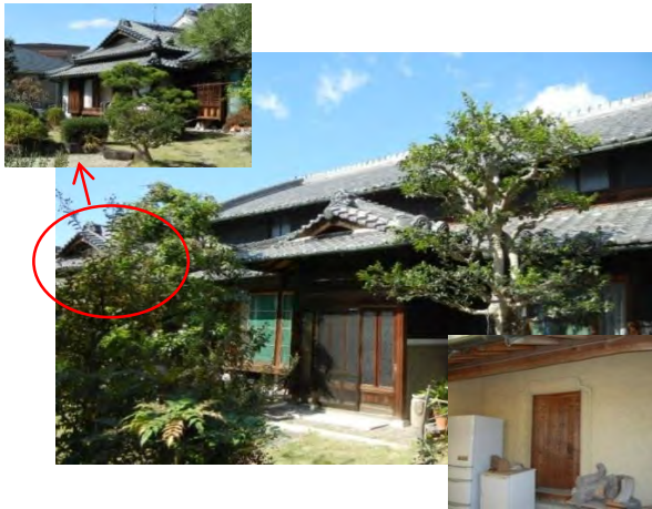
主屋 片側切妻片側入母屋(落棟) 外壁は上下階、黒漆喰仕上げ。中央の張出玄関の他、上手にも張出部を持つ。また土蔵は土塗り壁素地の仕上げ。
