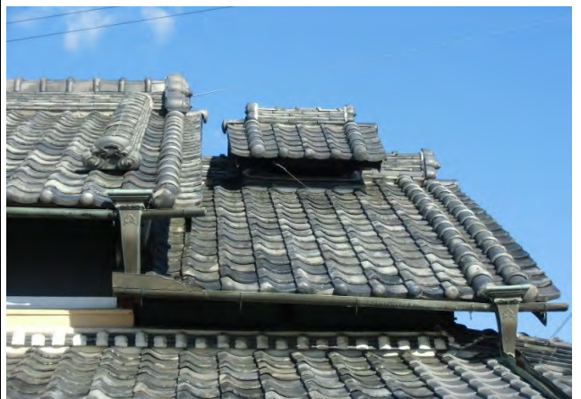
煙出し 煙出しも残されている。
