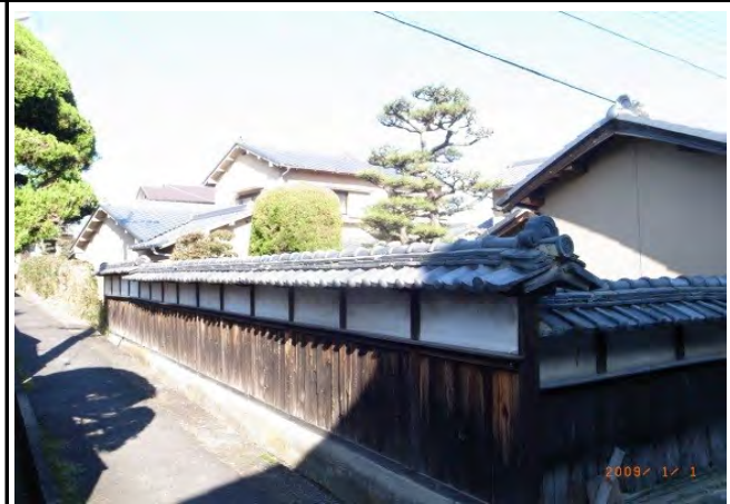
真壁塀 瓦葺屋根、漆喰壁、腰板張の真壁塀。
