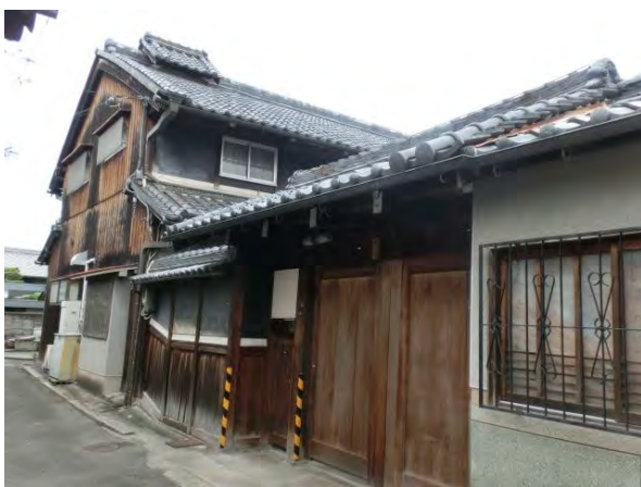
長屋門と主屋 西側の道路に面して長屋門を構える。主屋は屋根西側に煙出しがある。
