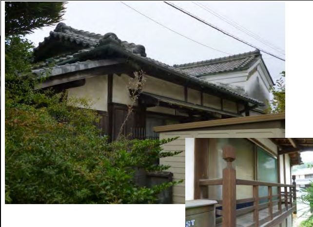
附属屋 離れは底を銅板葺きの吹き寄せ垂木とする。長屋門の窓には持ちだしの手摺が見られる。
