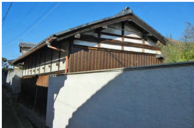
納屋 外部に突出した梁仕口の長ホゾが連続し、内部構造がうかがえるとともに、外観を特徴付けている。
