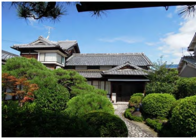
主屋 切妻 大きな張出玄関がある。
