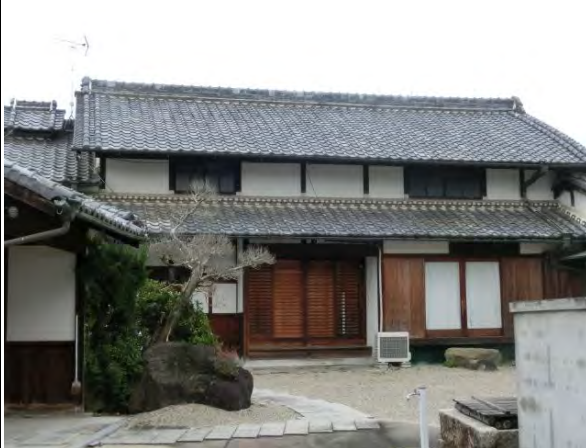
主屋 式台は農村では珍しい。大正期の建物と思われるが、一階部は江戸の可能性も。この建物も西側に煙出しがある。
