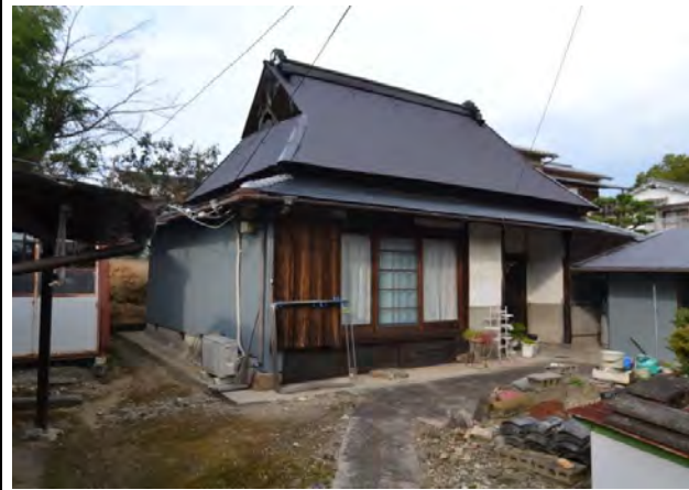
主屋 入母屋草葺屋根にトタン葺。近年の増改築の影響が少なく、古い時代の姿をよく留めている。
