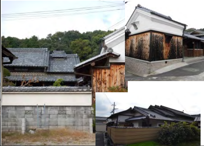
屋敷構え・主屋・土蔵 長屋門・土蔵・離れを備えた広い屋敷。主屋はつし二階。乾蔵は本瓦葺で古い。
