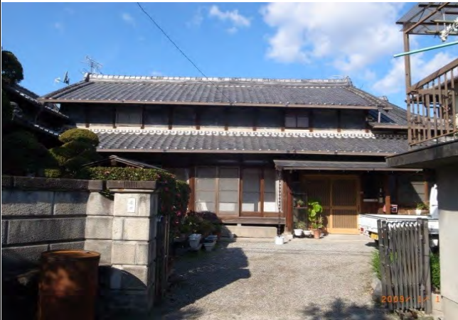
主屋 つし二階 つし二階、切妻、落棟、棧瓦葺。玉石基礎とする。背面側に井戸が残る。
