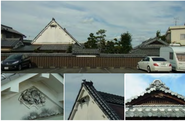
屋敷構え・主屋 典型的な「囲い造」の屋敷構えをもつ。また、妻には装飾を備える。
