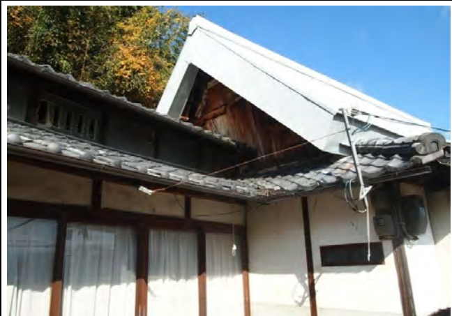
虫籠窓 主屋に接続した離れのつし二階部に虫籠窓が残る。
