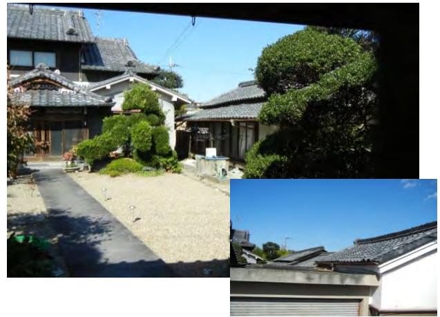
主屋 落棟部分は入母屋
