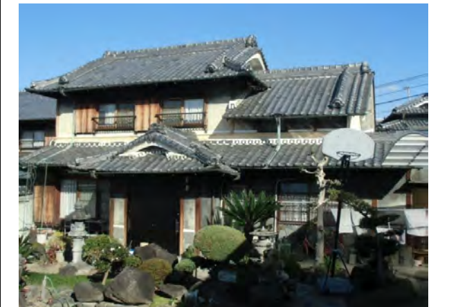
主屋 入母屋造 戦後に建築された農家で、屋根が入母屋、玄関も入母屋妻入りとなっている。
