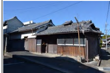
主屋 大和棟 主屋は明治27年(1894)建築。高塀造の大和棟。
