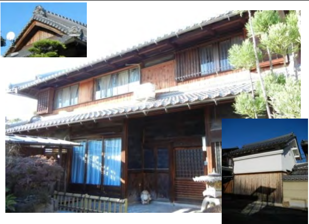
主屋 入母屋 本二階建 二階板張や開口廻りは新しい。妻に木連格子を備える。土蔵は置き屋根形式で妻壁頂部に紋様入り。
