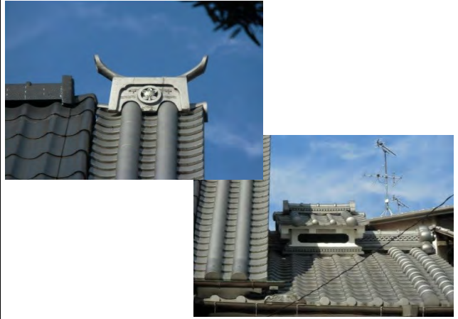
煙出し 10年前に屋根改修されたが、高塀の棟飾りは焼き直して再使用されたと聞く。落棟部の煙出しも残された。
