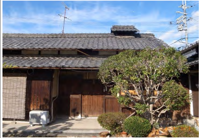
主屋 つし二階 束石建であるので戦前に建築されたと思われる。切妻棧瓦葺で大屋根に煙出しが残る。
