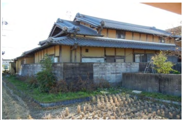
主屋 片側切妻片側入母屋(落棟) 外壁は土塗り壁素地仕上となっている。
