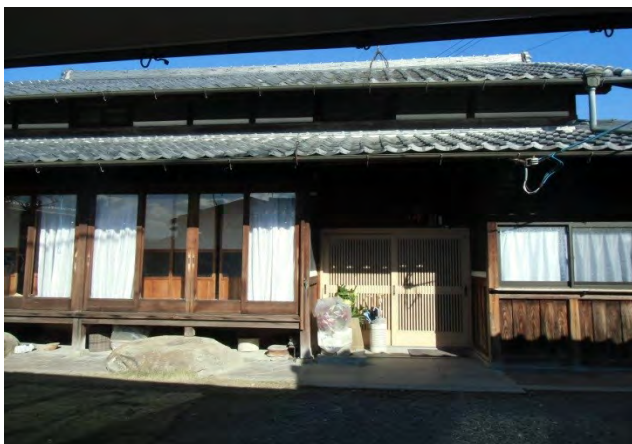
主屋 つし二階 大正～戦前頃に建築された農家で、切妻平入。
