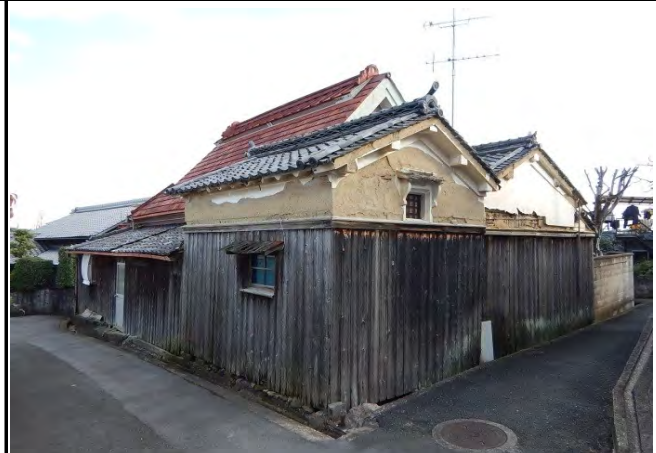
土蔵 乾蔵、腰壁部分にも窓がある。
