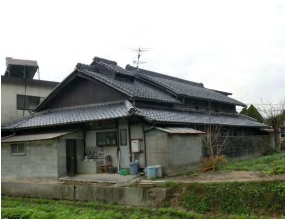
主屋 落棟の切妻屋根、煙出しがみられる。 戦前の建物とみられるが、美しく手入れされている。
