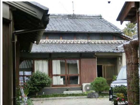
主屋 片側切妻片側入母屋の屋根、つし二階部は黒漆喰塗り。
