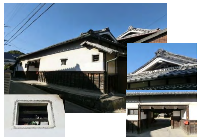
長屋門 元代官屋敷 入母屋屋根、漆喰塗大壁、開口廻りの鍔細工、与力窓、門扉の八双金具等、他では見られない意匠を持つ。
