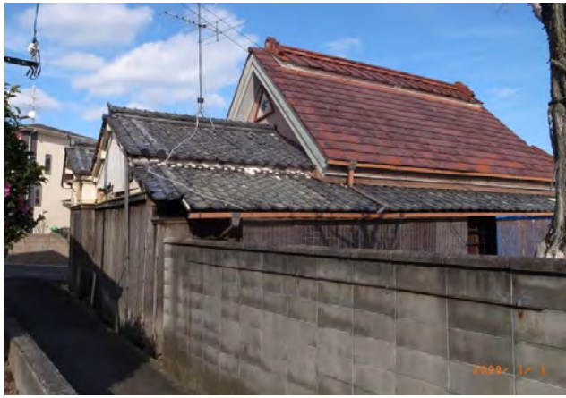
主屋 片側切妻片側入母屋 明治末頃に建築された農家。草葺の上に金属板葺。庇や上手の落棟は瓦葺。
