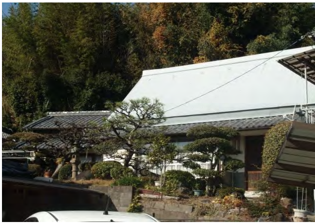
主屋 片側切妻片側入母屋 明治時代に建築されたとみられる農家。草葺であったが現在は金属板葺となっている。
