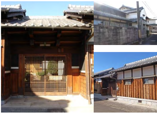
長屋門 門屋部を落棟・引違戸とした特徴的な構え。主屋は片側切妻片側入母屋（落棟）で、乾蔵が接続する。
