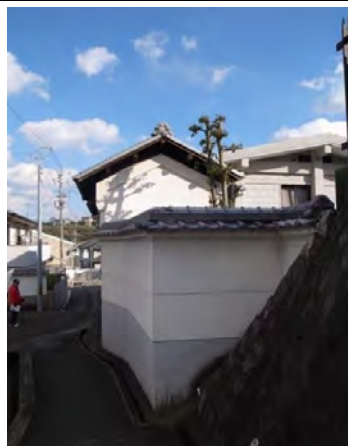
蔵と塀 昔からの石垣に併設する和の趣を取り入れた擁壁と蔵。
