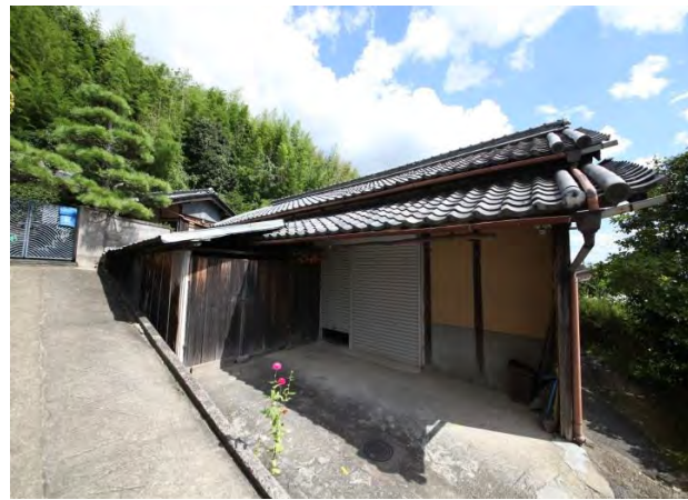
納屋 門の外にある納屋は土塗壁、延石基礎。
