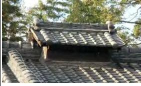
細部の意匠（虫籠窓・煙出し） 伝統的な意匠である、つし2階、虫籠窓、煙出し。
