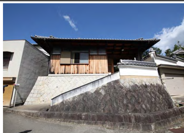
石垣 石垣が組み、伝統的な意匠の長屋門が建つ。
