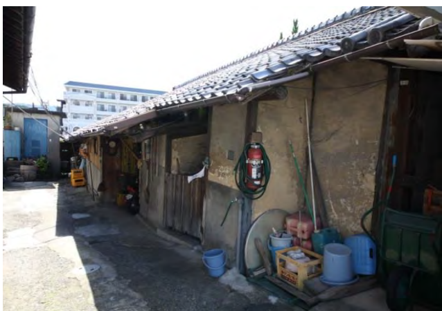
納屋 7号線沿いの附属屋。土塗り壁、瓦葺で趣がある。
