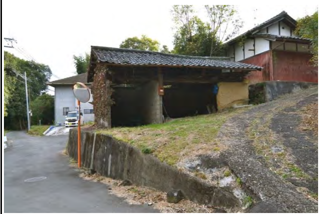
ドテ小屋 部分的にコンクリートブロックで改修されている。
