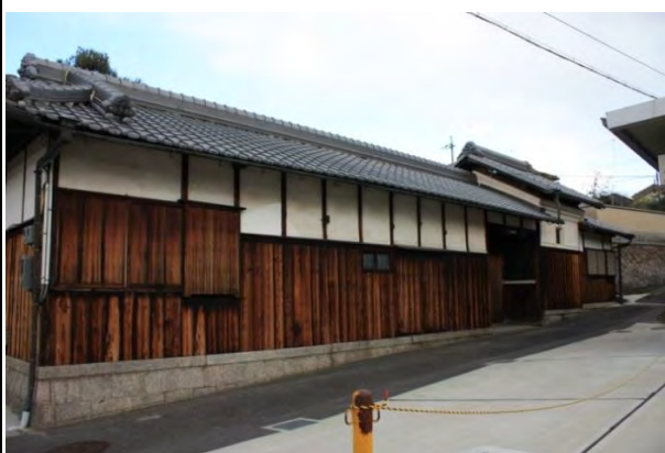
長屋門（蔵に接続） 腰壁板と漆喰で仕上げられた真壁造りの外壁。
