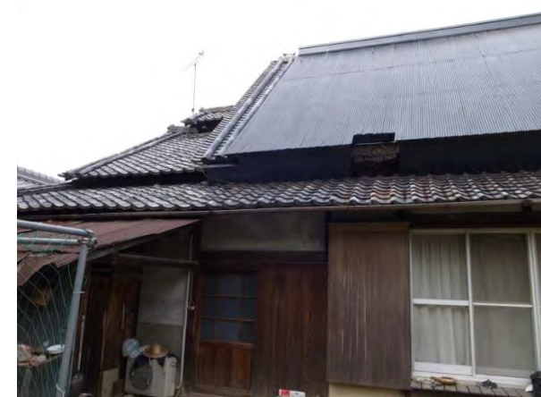
主屋 大和棟 珍しく西側の落棟に煙出しをもち、草葺の上のトタンの切欠きは小屋裏の通気用か。
