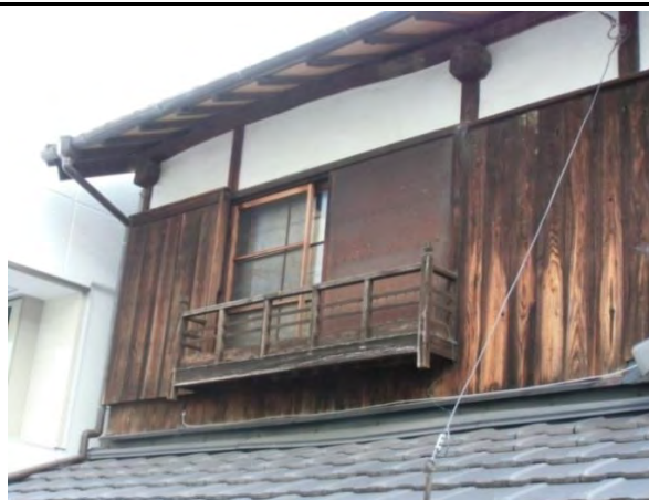
軒桁が折置き組で組まれた建物。梁丸太小口が現しで見える。
