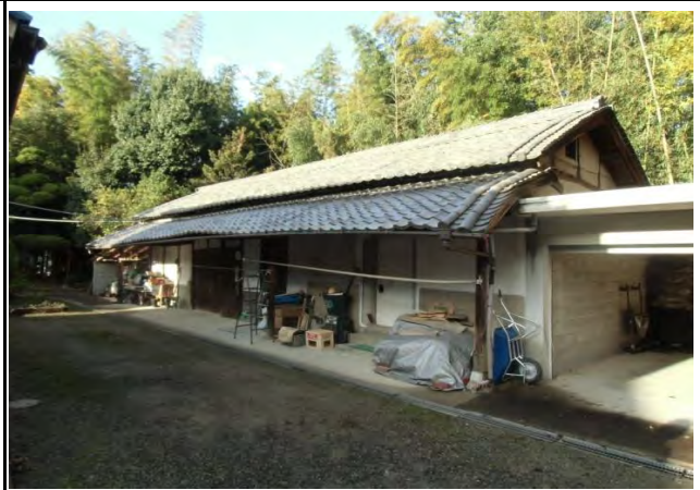
納屋 主屋に対して直行する形で建つことが多い。土庇の下の軒内空間は庭と納屋の中を緩やかに繋いでいる。
