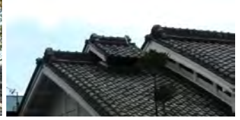
細部の意匠（虫籠窓・煙出し） 伝統的な意匠である、つし2階、虫籠窓、煙出し。
