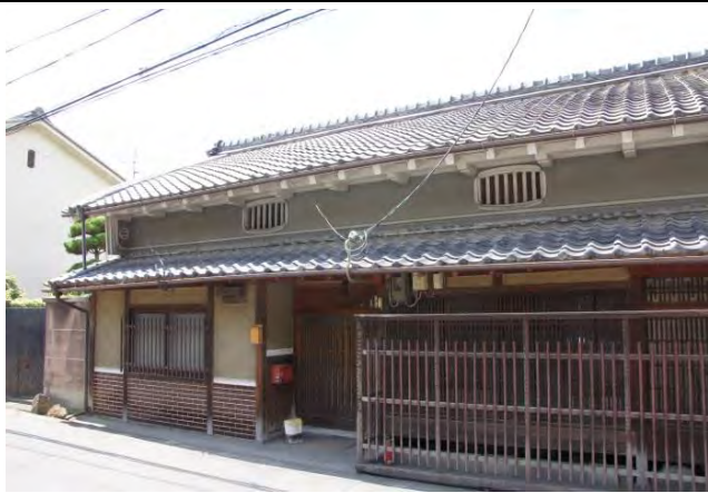
町家型主屋 つし二階 虫籠窓 袖うだつ 二階軒裏漆喰塗り込め 柱、梁、軒裏、格子は弁柄塗り。
