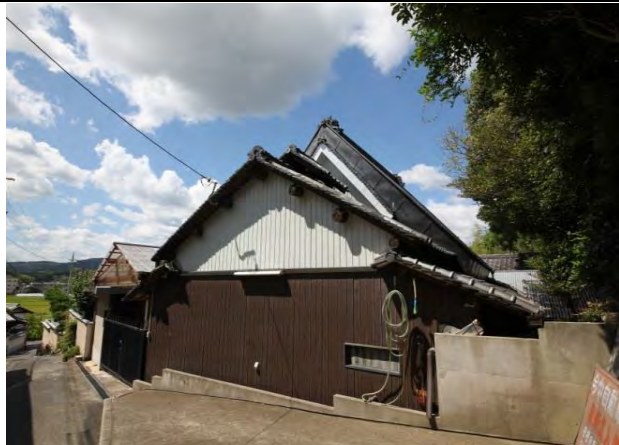
大和棟の主屋 鉄板葺で落棟に煙出しがある。
