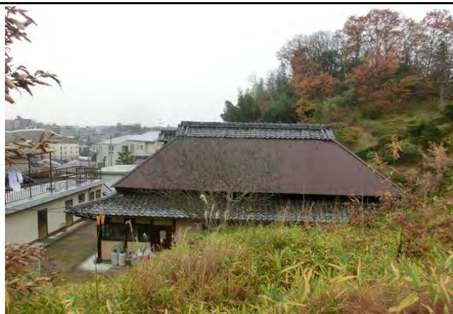
主屋 寄棟造（もと草葺） 主屋の妻面の煙出しに特徴あり。 北側から見た所。
