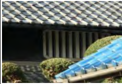
街道筋に面する町家住宅に見られた虫籠窓
