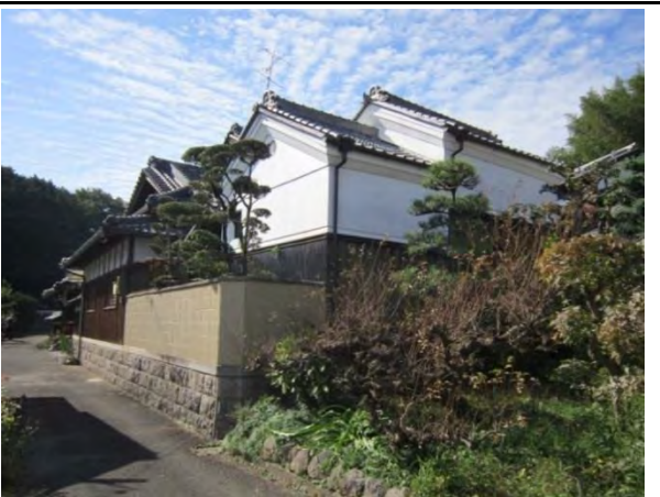
土蔵 昭和36年築のもので棟が2段に段違い。
