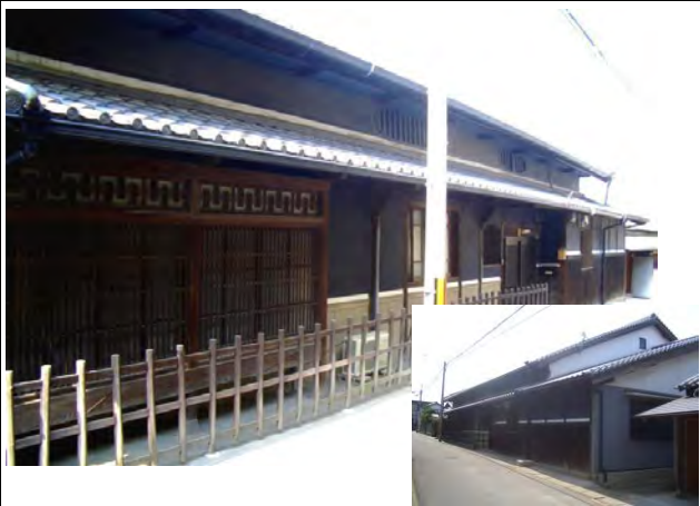
暗越奈良街道に面する町家 砂茶屋に残る間口の大きな町家型住宅。虫籠窓、出窓格子などの意匠の他に、社寺建築で見られる花頭窓が見られた。
