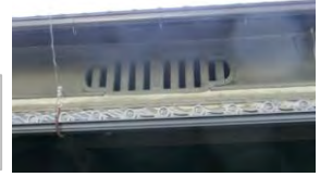
街道筋に面する町家住宅に見られた虫籠窓
