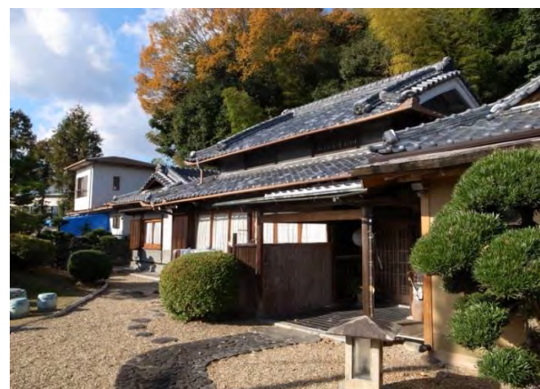
主屋 つし二階、入母屋造。 主屋と離れの屋根が接続している。
