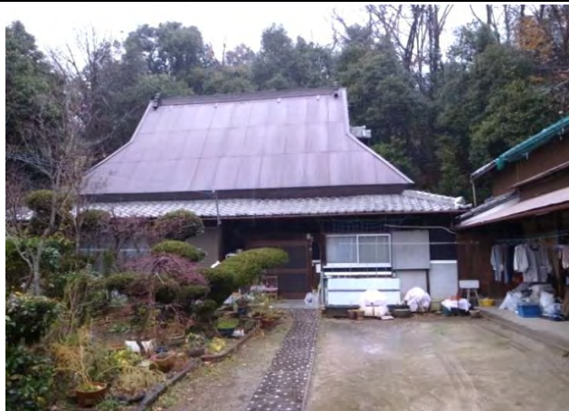
主屋 入母屋造（もと草葺） 東側妻面に煙出しが付く。
