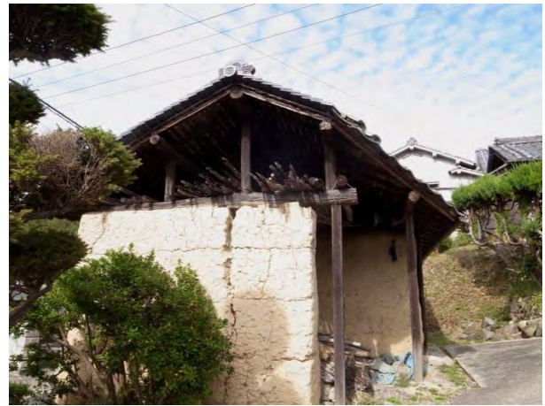
ドテ小屋 土壁の厚300程度ある。クラックの奥に竹小舞や木下地が何もないことが分かる。
