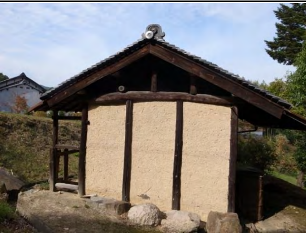
倉庫 他のドテ小屋とは異なり真壁づくりが端正な表情を作り出している。
