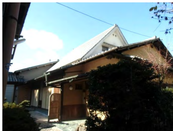
主屋 大和棟 改修されたと思われる大和棟。
