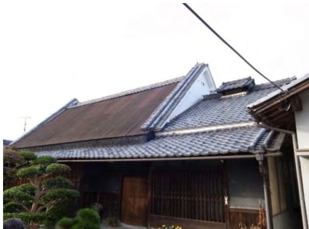
主屋 大和棟 敷地内に長屋門、ドテ小屋、手入れされた庭があり、昔からの形態をよく残している。
