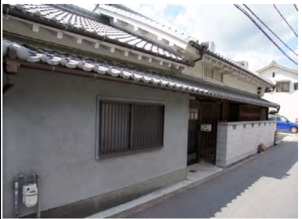
町家型主屋 つし二階 虫籠窓 袖うだつ 玄関周りには弁柄塗りが見られる。
