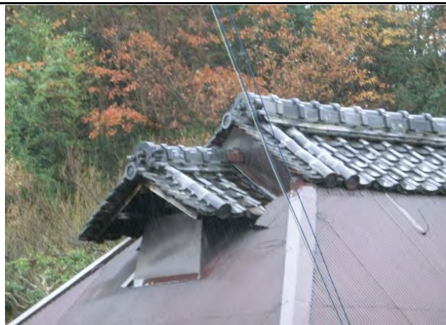
寄棟造の煙出し(拡大) 寄棟造の屋根に付く煙出し。煙出しの位置は土 間付近か。
