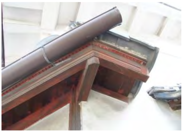
下屋軒先、けらば、軒裏に細かい細工がされている。
