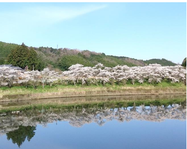
写真：須川ダム
