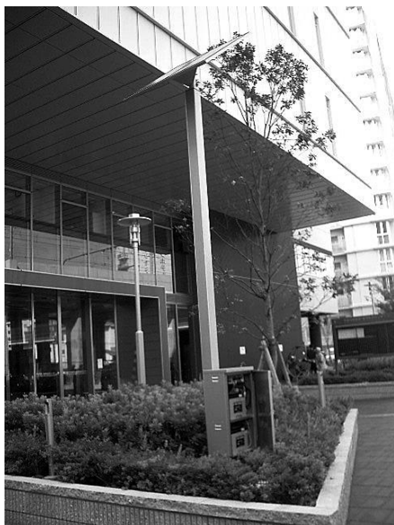
蓄電池・太陽電池付き街路灯 (奈良市はぐくみセンター) 写真提供：サークルおてんとさん
