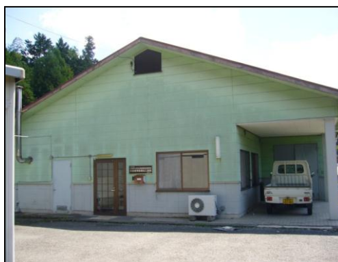
< 都祁農畜産物処理加工施設 >
