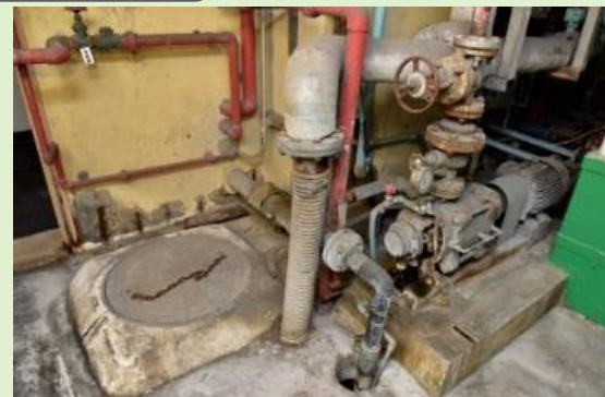
壁がはがれ、鉄筋がむき出しに
