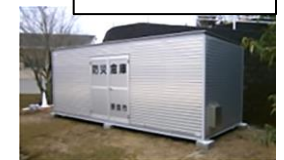
分散備蓄倉庫
