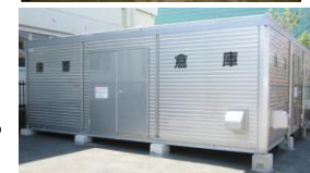
集中備蓄倉庫
