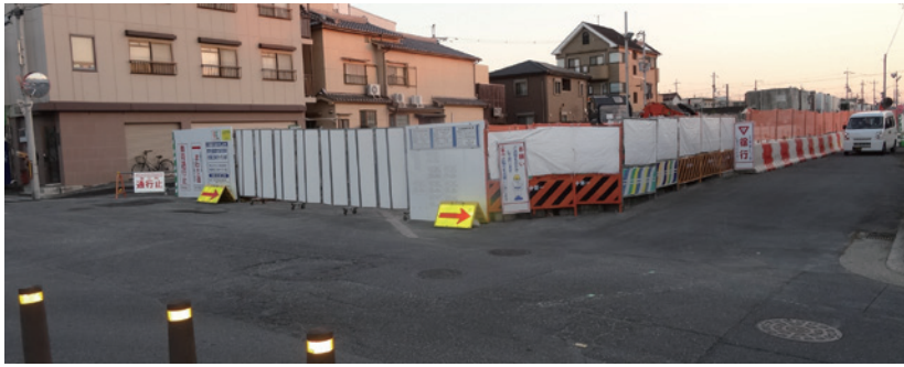
工事が進められている六条奈良阪線
