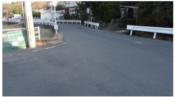
横断歩道がなく危険な通学路(山陵町)
