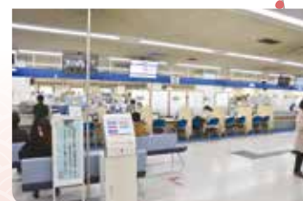
鉄骨ブレース（写真上）の設置や、天井・壁等を改修。システム等を導入し、各窓口も大きくリニューアル（写真下）
