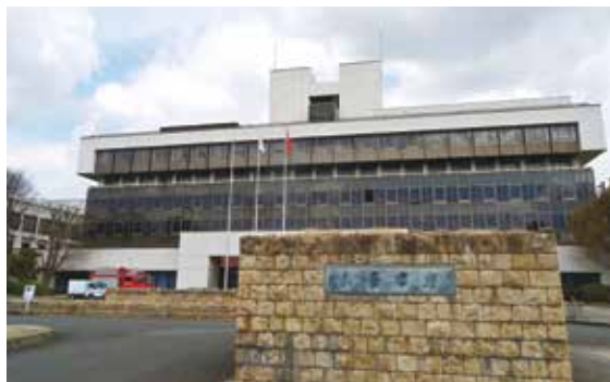
周辺環境に配慮した耐震化を（市役所本庁舎）
