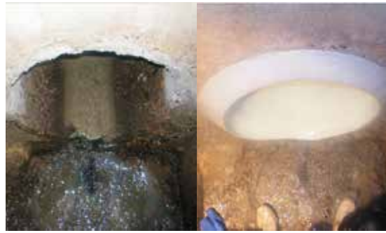
補修前の下水管(左)と補修後の下水管(右)
