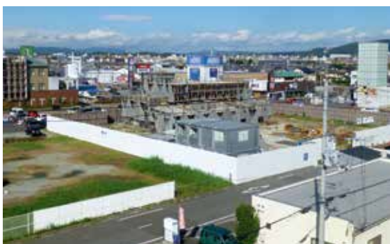
どうする？運営体制（建設中の休日夜間応急診療所）
