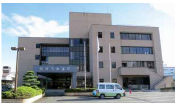
奈良市水道局本庁舎(法華寺町)
