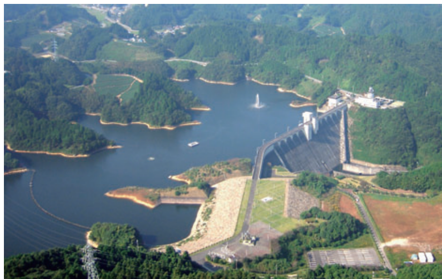
割賦負担金を償還中の布目ダム
