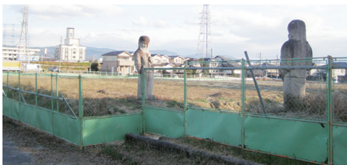
子どもセンター建設予定地（柏木町）
