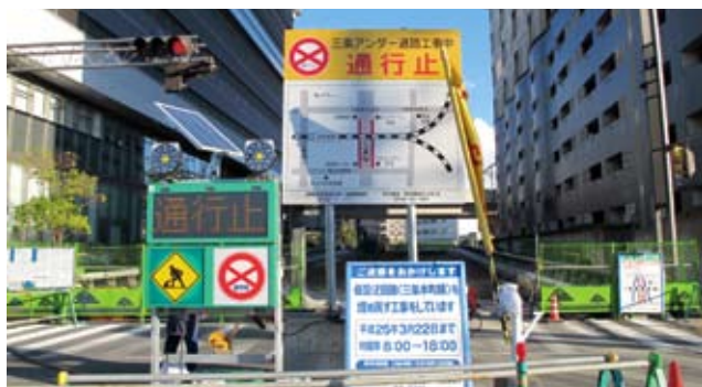
埋め戻し工事中のアンダーパス（三条本町）
