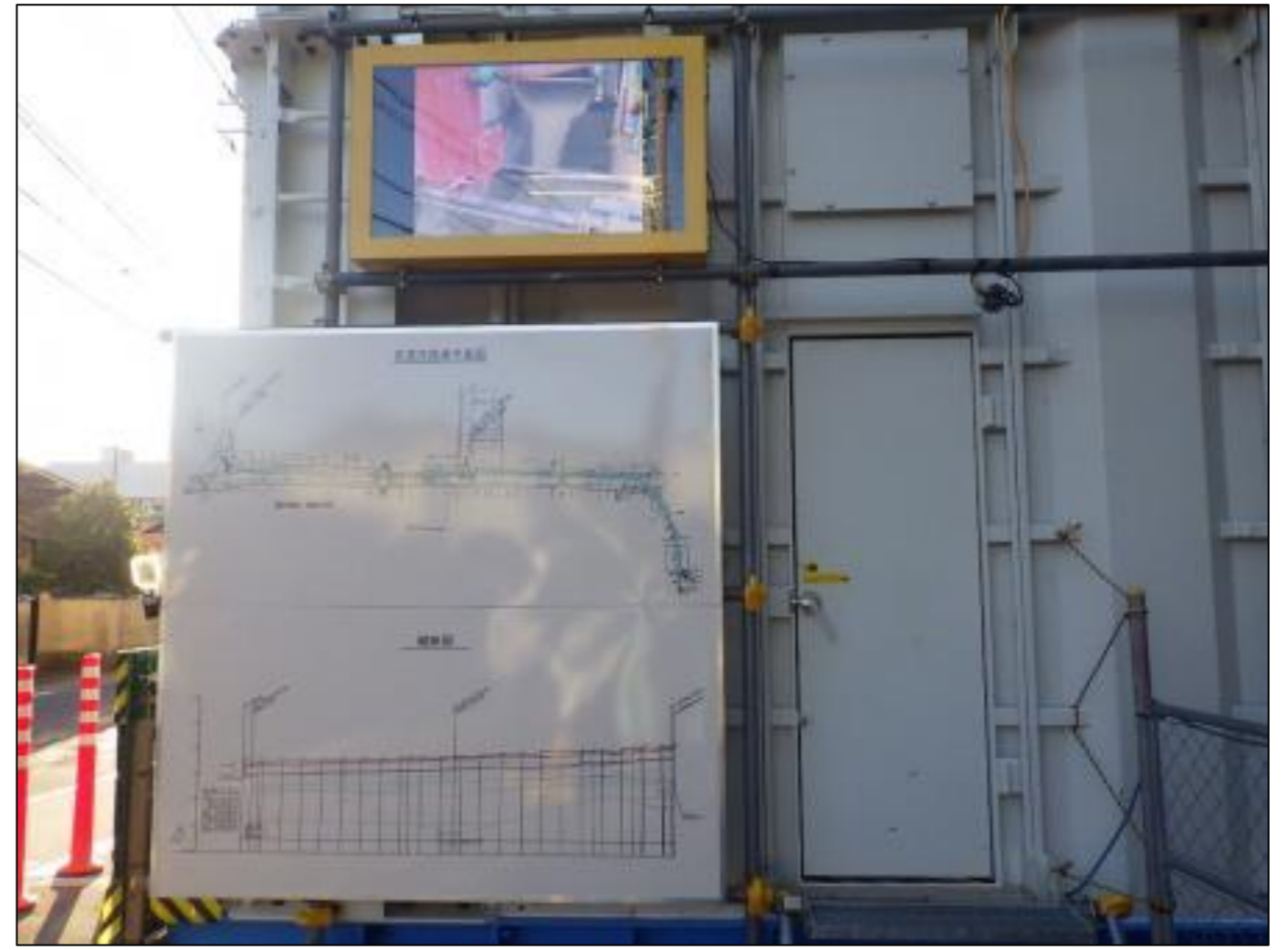
防音ハウスの屋外にモニターと案内板を設置
