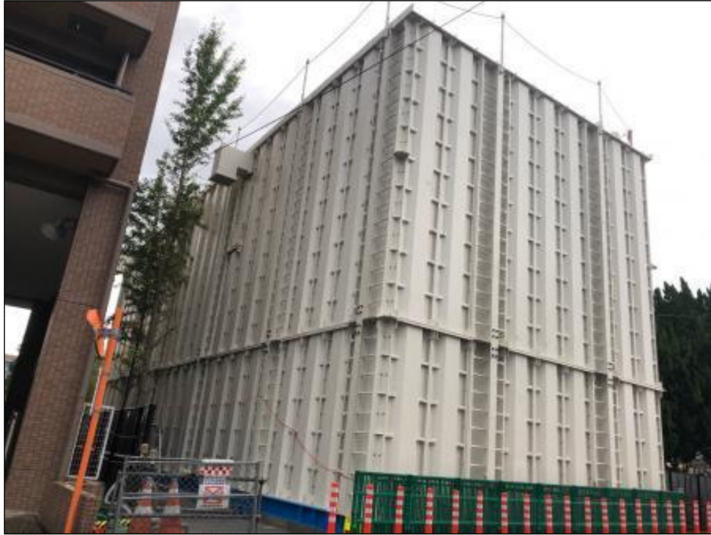
防音ハウス全景
