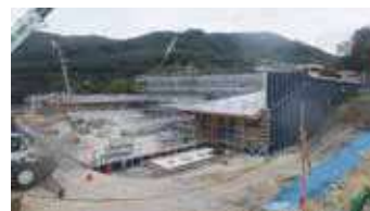
建築工事(北西から全景)
