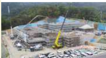
敷地造成工事(南西から全景)
