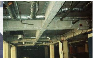
鉄骨を被覆して保護 石綿含有耐火被覆材
