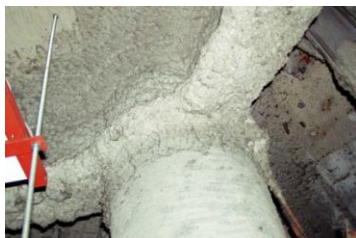
柱や梁に施工 吹付け石綿
