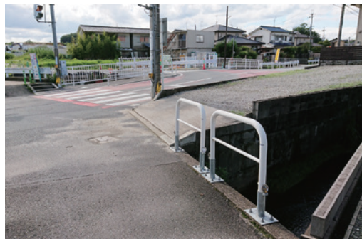
転落防止の柵が設置された通学路
