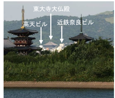
■ 遠景の市街地の建築物による眺望景観の阻害状況
