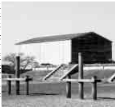
工事が進む第一次大極殿復原事業
