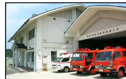
東消防署東部分署
