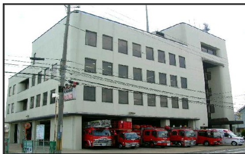
消防局・南消防署併設庁舎
