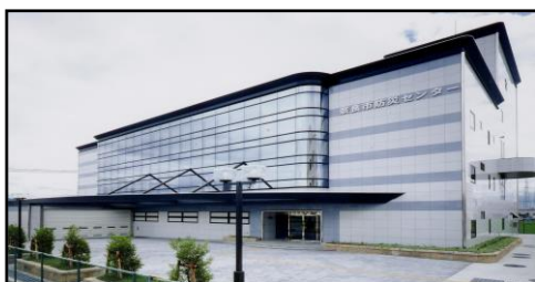
防災センター
