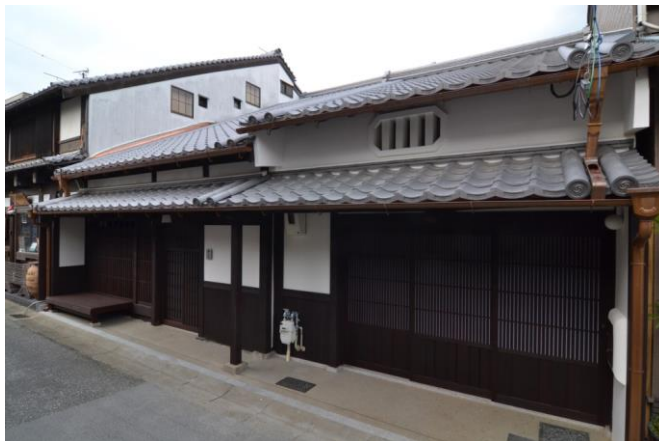
詳細調査:豊崎家 正面全景
