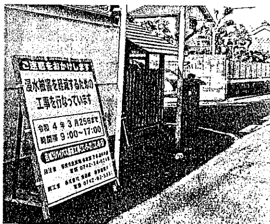
下水道工事が始まる(川久保町付近)
