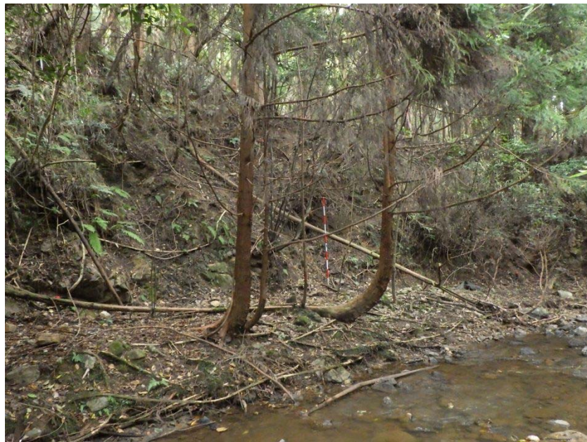
写真 3-3-7. 岩井川左岸の露頭欠如箇所 (図 3-3-1 の写真番号⑦) S-2 測線の起点より、岩井川沿いに 120m 程度上流の左岸側の露頭欠如箇所。 壁面は、岩塊混じり土砂状呈す。旧崩壊地形と考えられる。
